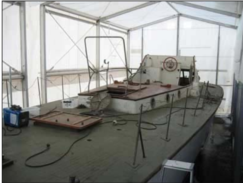
Taisto 3 korjauksen alkaessa talvella 2004. Kuva: Mikko Meronen.
